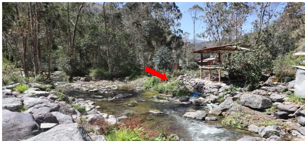
FIGURA N°03: SE OBSERVA QUE LA UNICA DEFENSA RIBEREÑA QUE CUENTAN ES CON PIEDRAS PIRCADAS, LO CUAL NO GARANTIZA LA SEGURIDAD FRENTE AL INCREMENTO DE CUADAL DEL RIO ULCUMAYO (RIO
