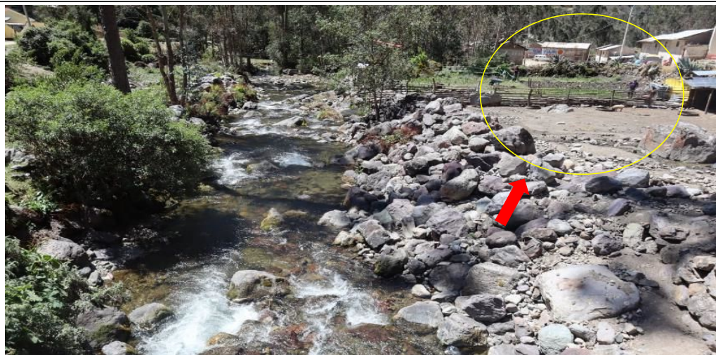
FIGURA N°02: SE OBSERVA SEGUN LA FOTO QUE SOLO LA DEFENSA NATURAL QUE PROTEGE A LAS VIVIENDAS SON SOLO ROCAS AMONTONADAS NO HAY NINGUNA PROTECCION TECNICA ESTRUCTURAL.
